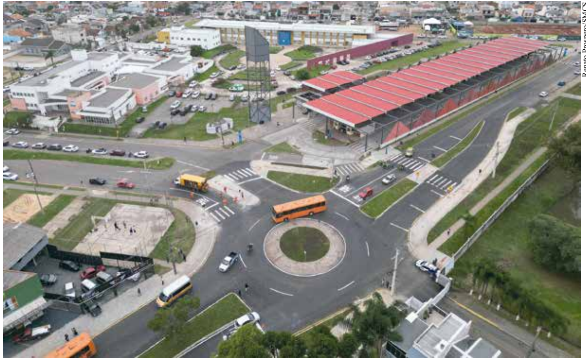
Obra da Prefeitura de Curitiba para correção geométrica e nova rotatória organizam o trânsito em vias movimentadas do Tatuquara
